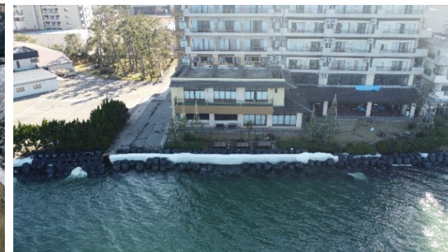
大型土のう設置(応急復旧)
