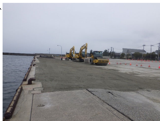
応急復旧完了(3月4日)
