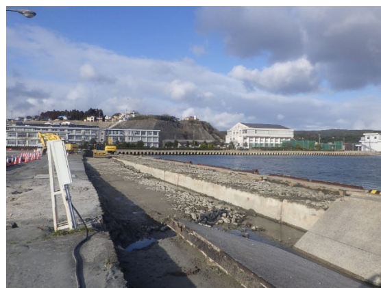
応急復旧工事(コンクリート版撤去)
