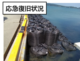
応急復旧工事完了
