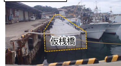
①仮棧橋設置状況(4月23日)
