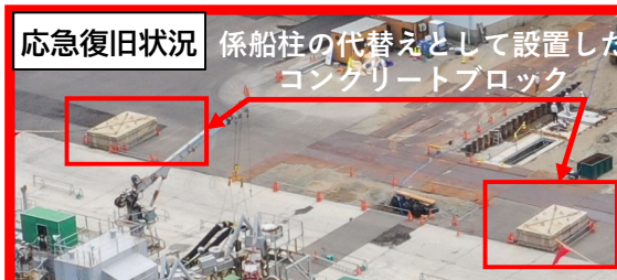
応急復旧後の利用状況
