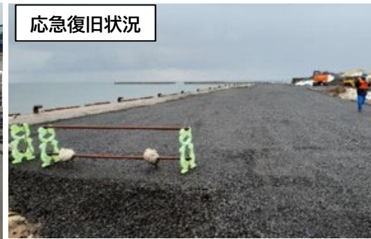
岸壁(-4.5m)応急復旧状況 (1/9完了)
