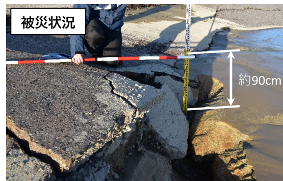
液状化によるエプロンの沈下(2号岸壁)
