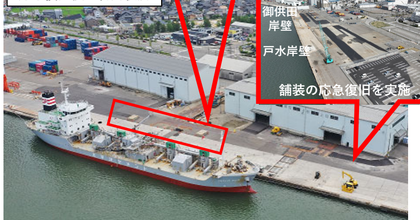
御供田1号岸壁(-10m)にてコンクリートブロックに係船柱として能登半島地震後初めて金沢港にセメント船が入港(6月5日)
