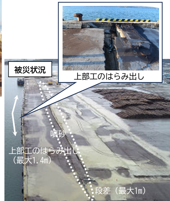
岸壁法線のずれと噴砂(物専岸壁)
