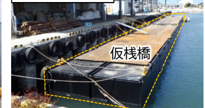
②仮棧橋設置状況(6月26日)
