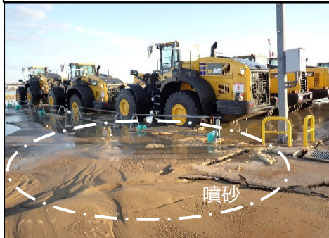
地震による裏埋土の液状化
