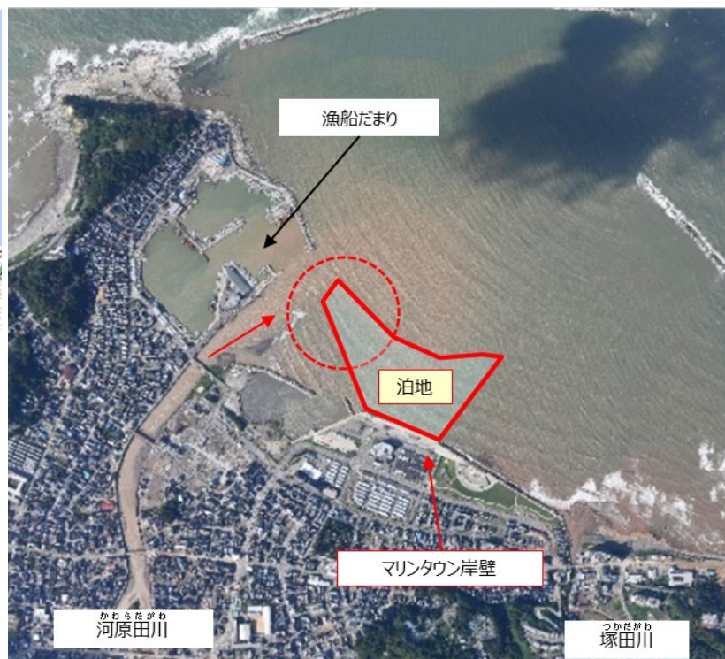
マリンタウン岸壁泊地の被災状況 (埋塞：河川からの土砂流入)
