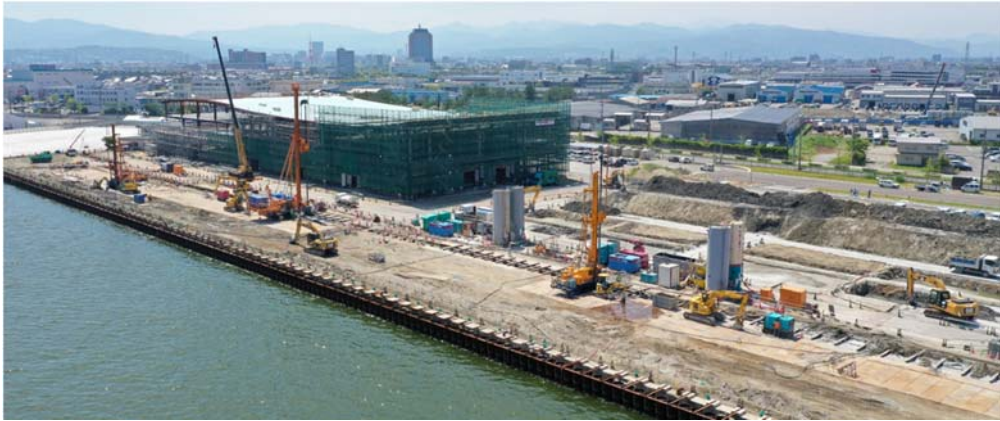
金沢港無量寺岸壁 施工状況
