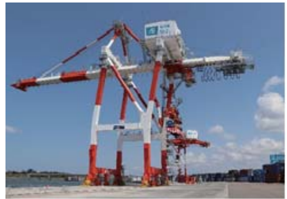
ガントリークレーン2号機
